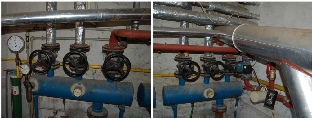
Obr. 3: Rozdeľovač a zberač
