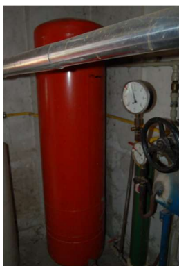
Obr. 4: Expanzná nádoba
