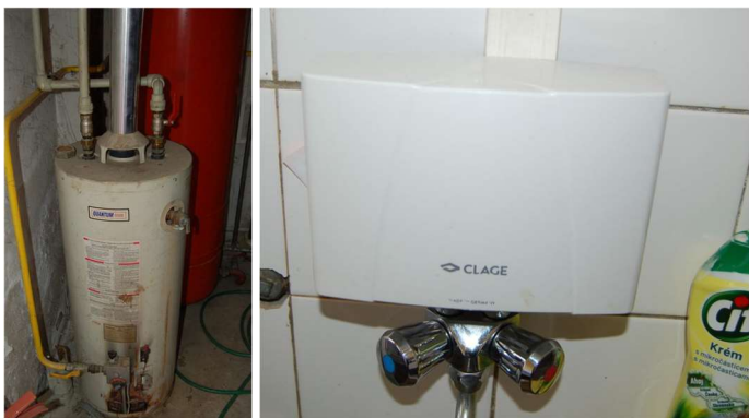
Obr. 6: Plynový zásobníkový ohrievač a elektrický prietokový ohrievač
