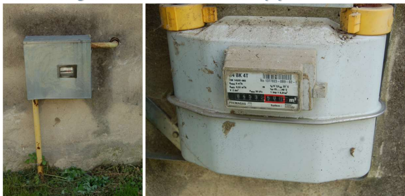
Obr. 12: Regulačné a meracie zariadenie plynu.
