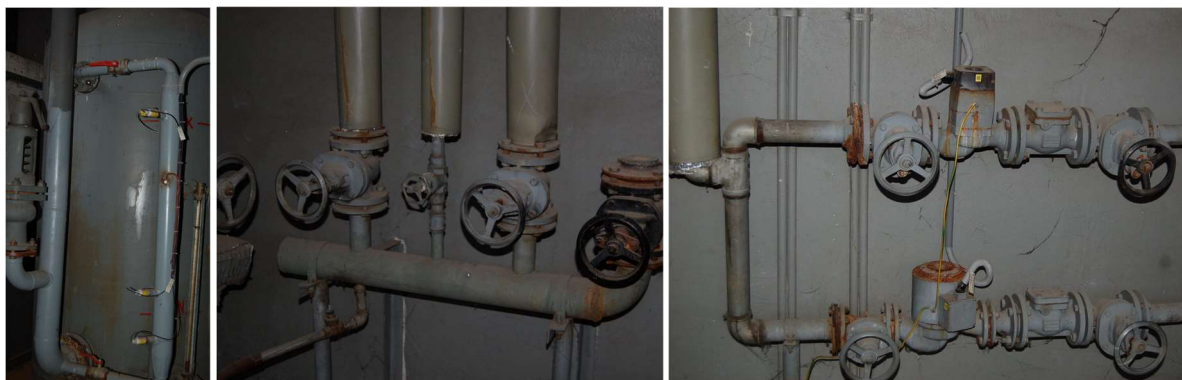
Obr. 7: Zásobníkový ohrievač na ohrev TV v kotolni, rozdeľovač a zberač, cirkulačné čerpadlá
