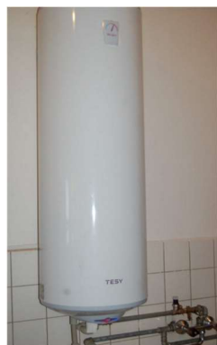
Obr. 8: Zásobníkový elektrický ohrievač na ohrev TV
