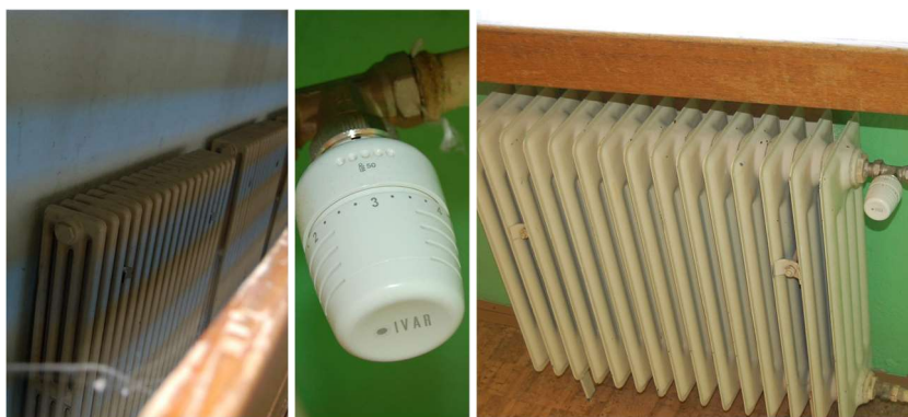
Obr. 6: Vykurovacia sústava – vykurovacie telesá a termostatické hlavice
